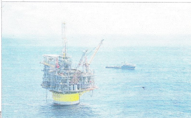
La partie émergée de la spar Perdido de Shell, dans le golfe du Mexique. La hauteur immergée est quatre fois plus importante.
